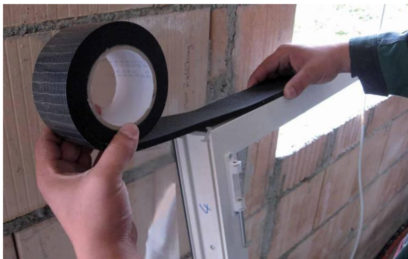
Slika 31 Sustav brtvljenja pomoću brtvenih traka (ILSAD, 2024)
