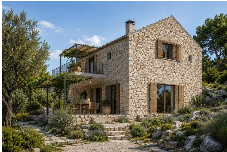
Slika 1 Kuća od kamena
