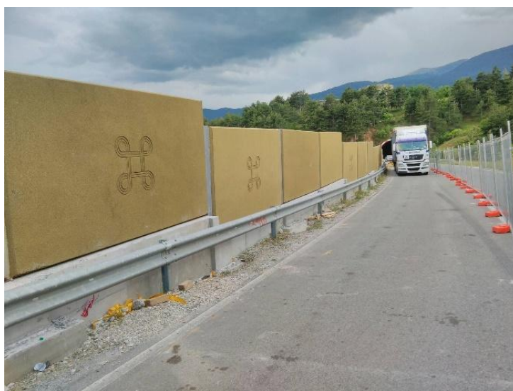
Slika 23 RUCONBAR - zidni panel za zaštitu od buke (Beton Lučko, 2024)
