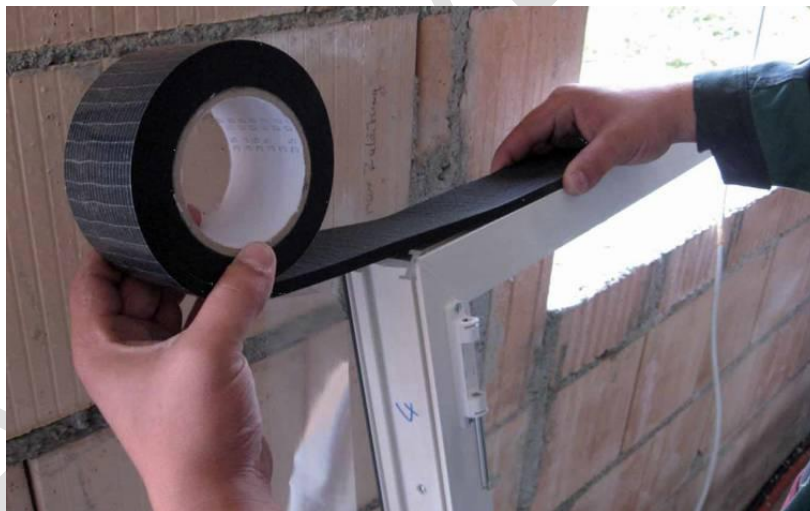
Slika 92 Sustav brtvljenja pomoću brtvenih traka (ILSAD, 2024)
