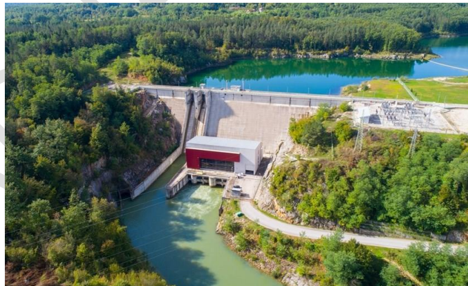
Slika 14 Primjer hidroelektrane (Lešće) (HEP Proizvodnja d.o.o. , 2024)
