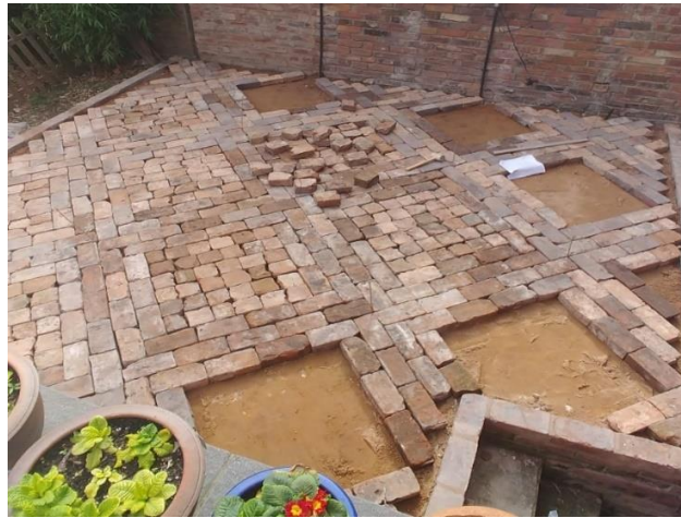
Slika 5 Opeka koja je nakon rušenja zida ponovno upotrebljena za popoločenje dvorišta (Araujo, 2024)
