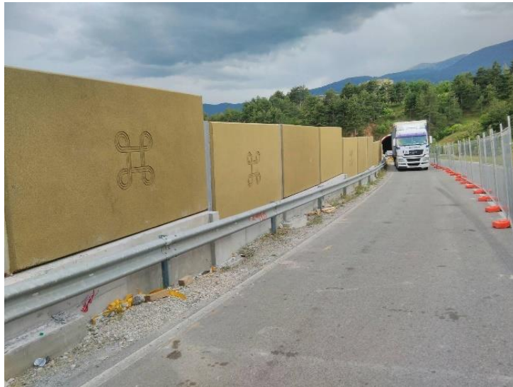
Slika 23 RUCONBAR - Zidni panel za zaštitu od buke (Beton Lučko, 2024)
