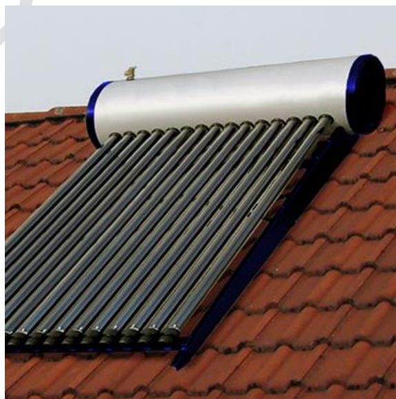
Slika 11 Solarni kolektor bez tlaka u kolektoru za grijanje vode (Gomon, 2024)
