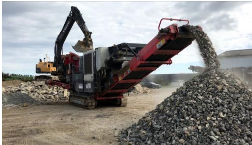
Slika 7 Drobilica betona na gradilištu (AXYO EQUIPEMENTS DE RECYCLAGE, 2017)
