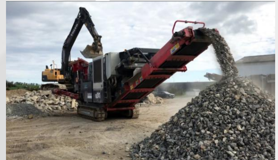
Drobilica betona na gradilištu
