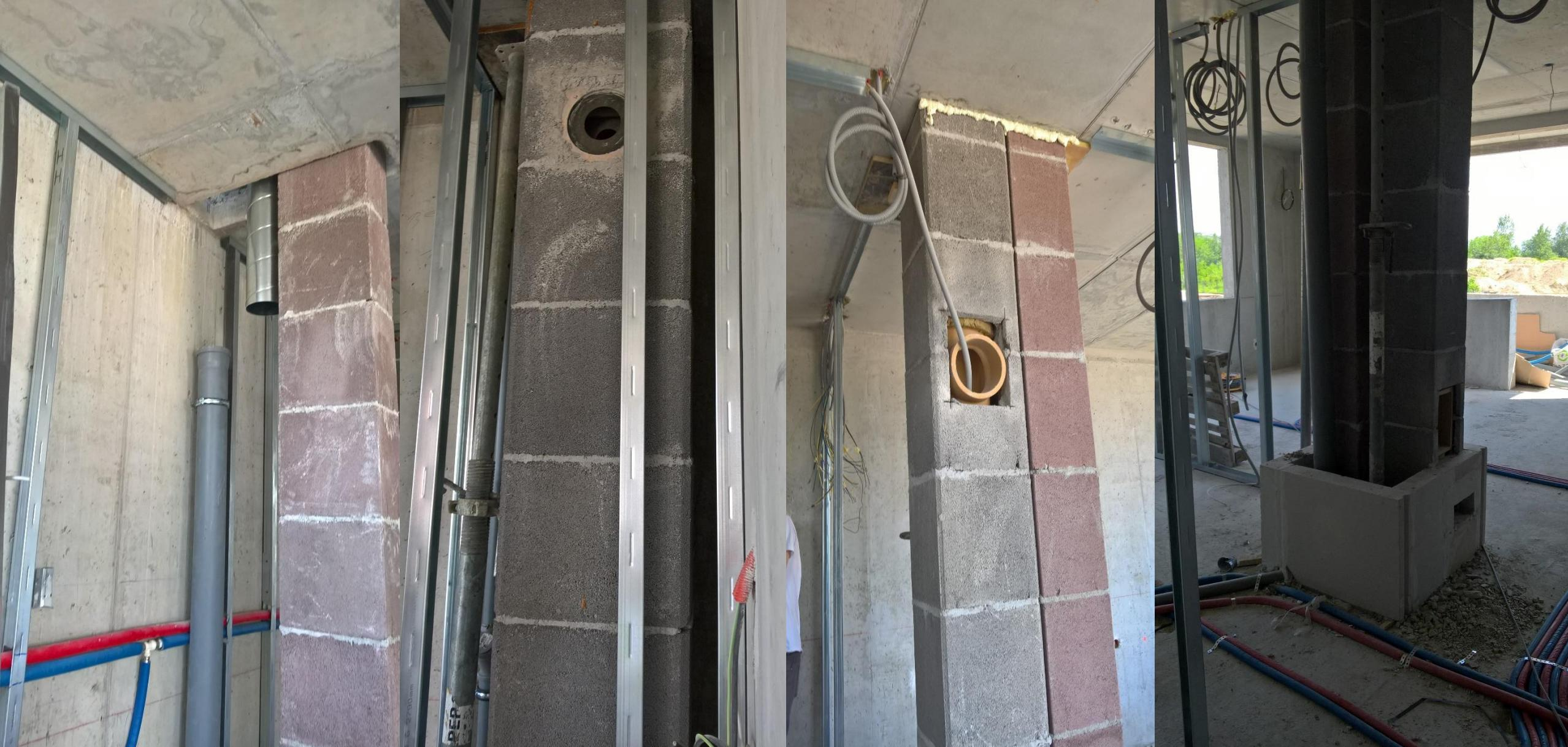
Hrvatski propisi zahtijevaju da unutar jednog stana postoje dva dimnjaka: plinski dimnjak i za kruto gorivo, ako se radi o etažnom grijanju. Ako je zgrada priključena na toplanu također mora biti jedan „rezervni dimnjak”, montažni dimnjak
